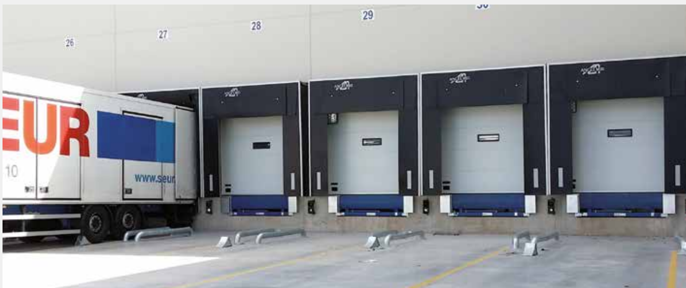
Calzos de seguridad y rampas hidráulicas modelo HIDRA .
