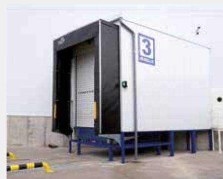
Construcción de muelle BOX B2 con inclinación de 45° a la nave industrial.
