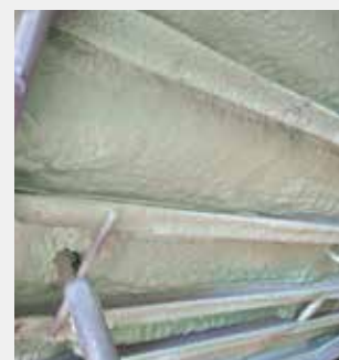
Aislamiento inferior en las rampas mediante espuma de poliuretano
