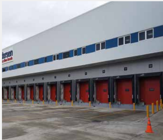
Muelles de carga refrigerados con Sistema Isoperfect .
