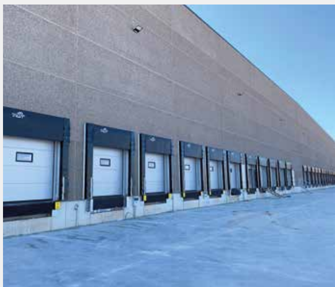
Mini ramp, abrigo de muelle fijo AC y puertas seccionales.
