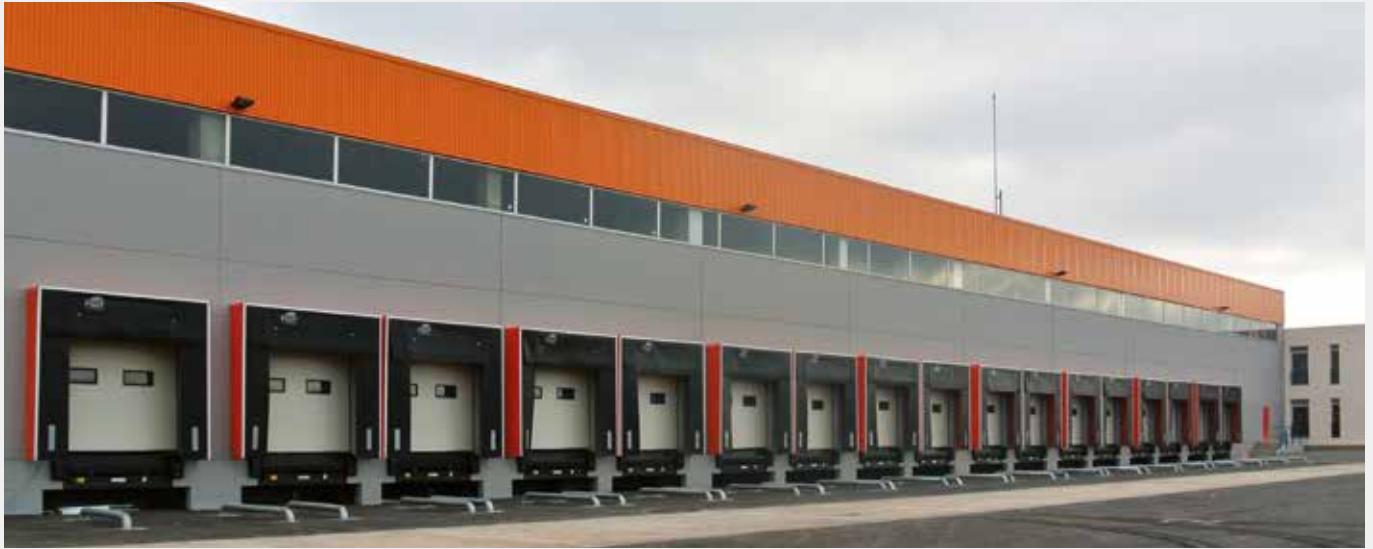
Rampa HIDRA con trampilla.
