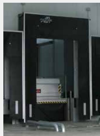
Mesa elevadora instalada en el interior con pasarela de aluminio
