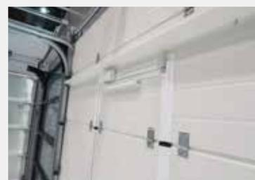
Detalle muelle retenedor y micro de seguridad.
