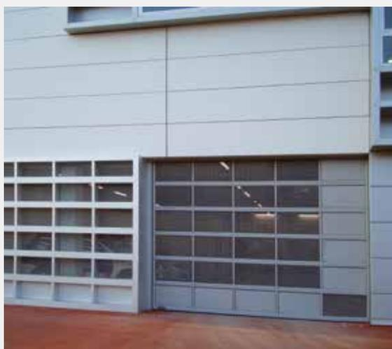
Puerta seccional **Alu-Secc**® con chapa perforada.
