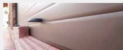
Detalle de la junta de estanqueidad.
