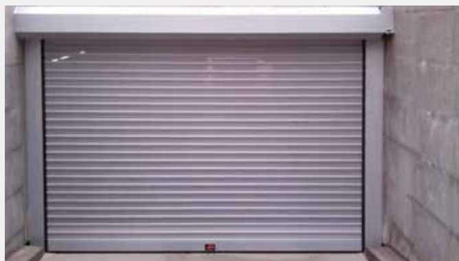
Puerta Alumir PS instalada por el exterior.
