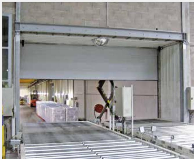
Puerta enrollable cortafuegos **EI-Roll Basic**® en línea de rodillos.
