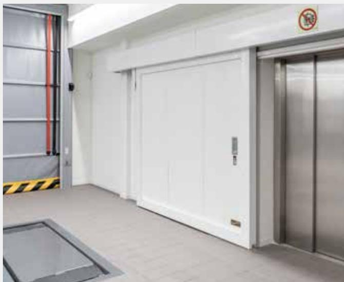
Puerta **corredera** cortafuegos delante de montacargas.
