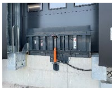
Pasarelas de carga
